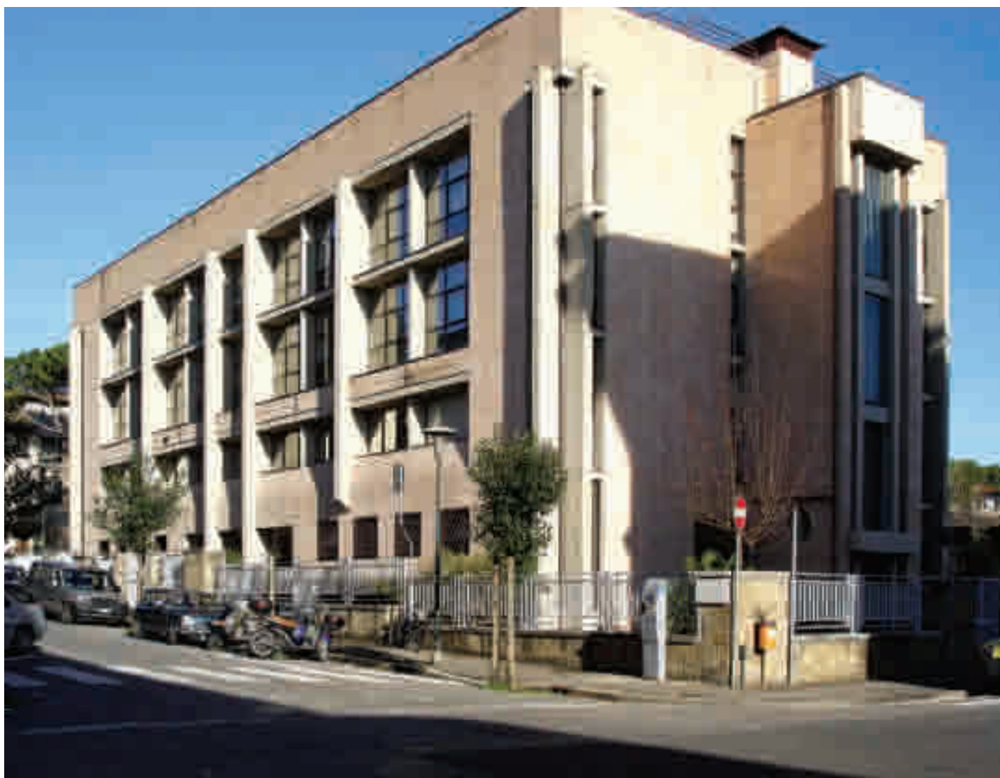
Centro didattico dell'Istituto, la facciata (fotografia di A. Bigazzi, IAO)
