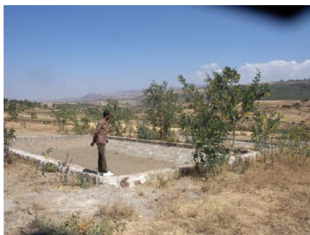
Ph. 37: Sludge dry beds
