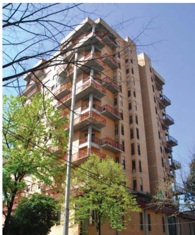
Torre Drin, Sede UTL
