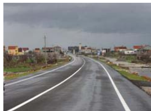
Strada Scutari-Hani dopo la fine dei lavori
