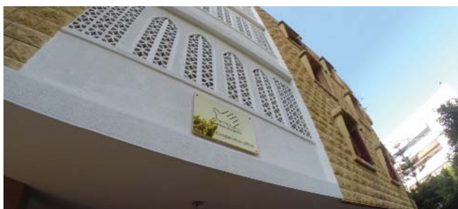
L'Ufficio di Cooperazione Italiana in Libano, a Beirut, nell'area di Baabda da cui si raggiungono facilmente tutte le regioni del Paese (© UTL Libano-Siria / Vincenzo Schiano Lomoriello)
