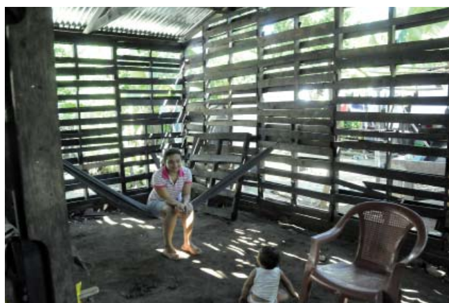
Struttura di una casa costruita con pallet immersi nell'olio esausto a El Viejo Africa70
