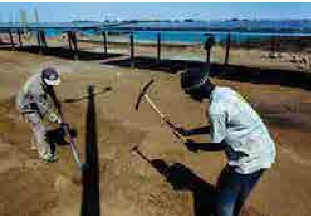
Lavori di costruzione del perimetro di protezione dei pannelli solari. Istituti grazie al progetto Green-Cross/Enea, questi pannelli alimenteranno le pompe d'acqua destinate all'irrigazione del nuovo campo agricolo. Bokhol, Senegal.
