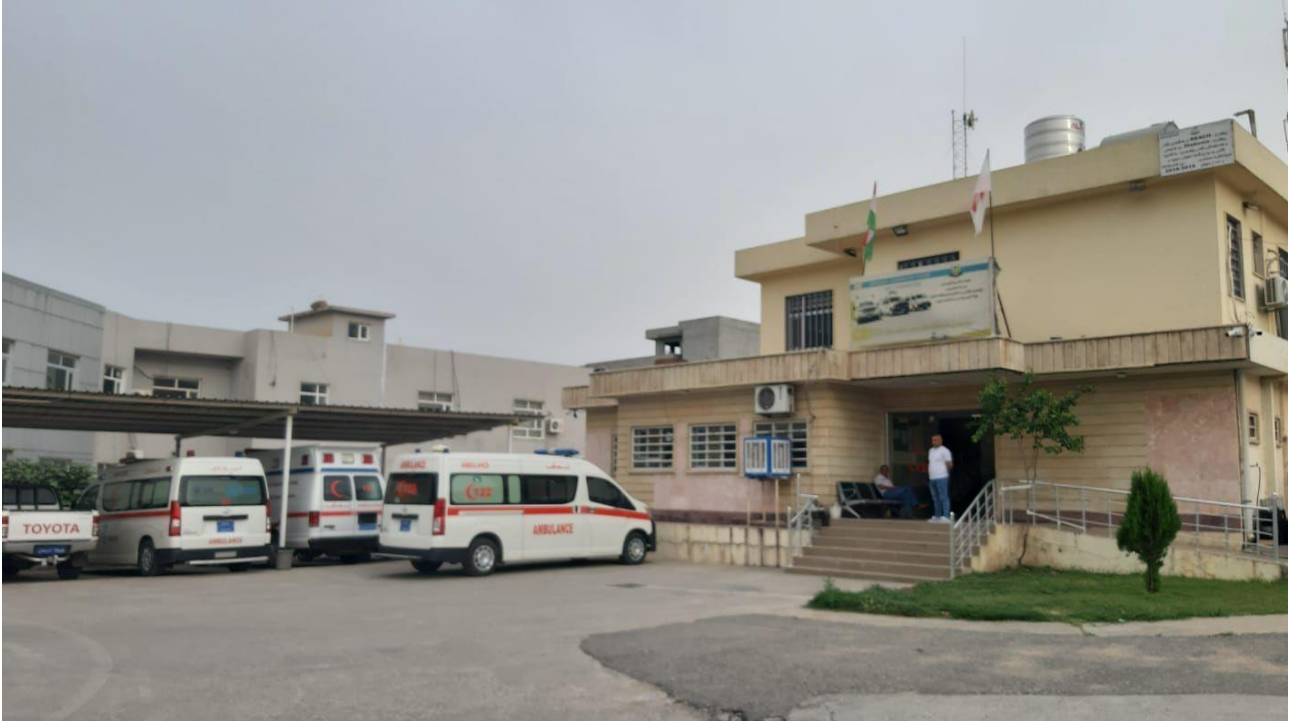
Sede del Servizio di Emergenza 122 a Duhok – Maggio 2023
