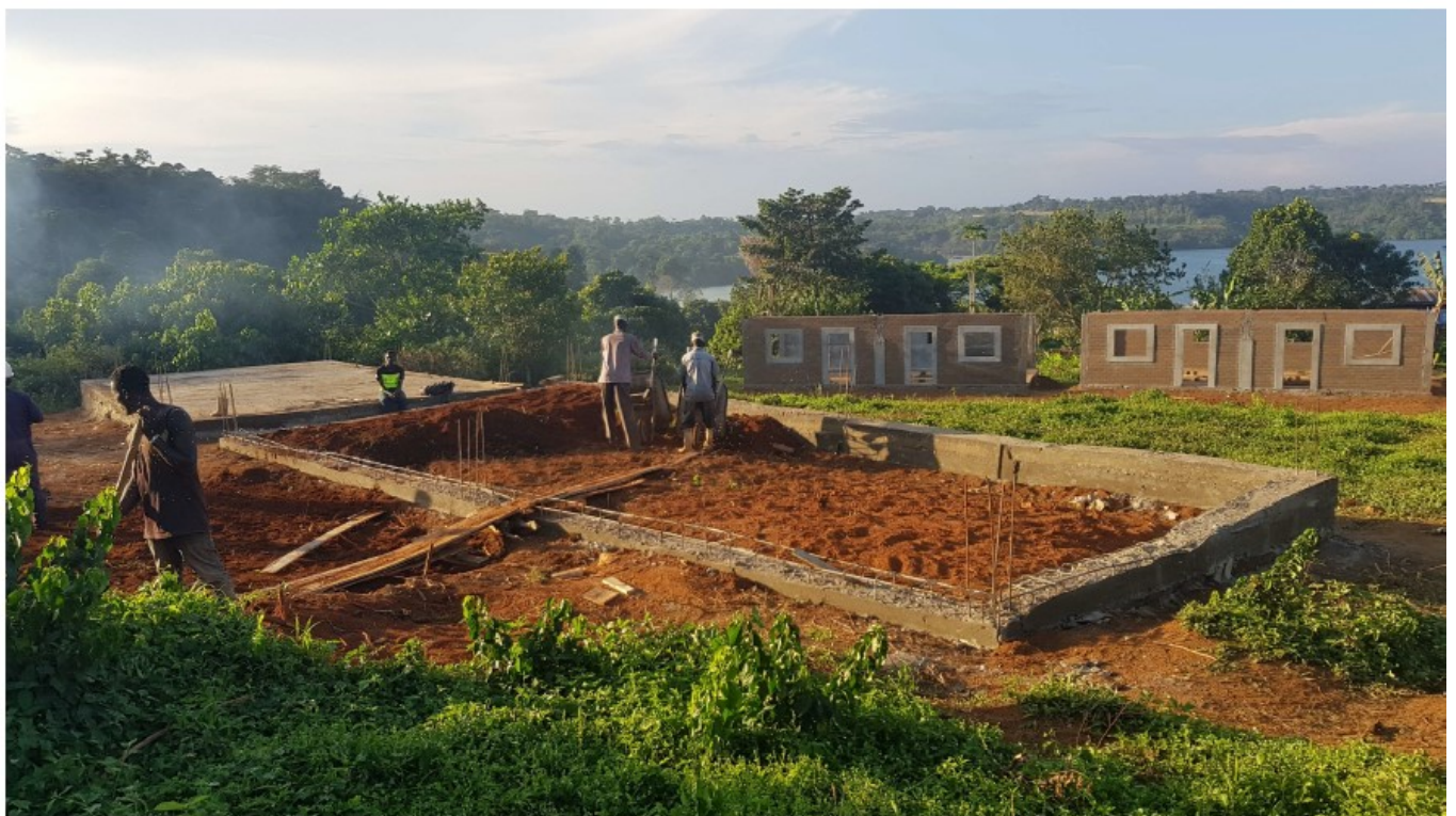
Immagine 5 - Operazioni di costruzione della seconda fila di case dell’Absolute Village
