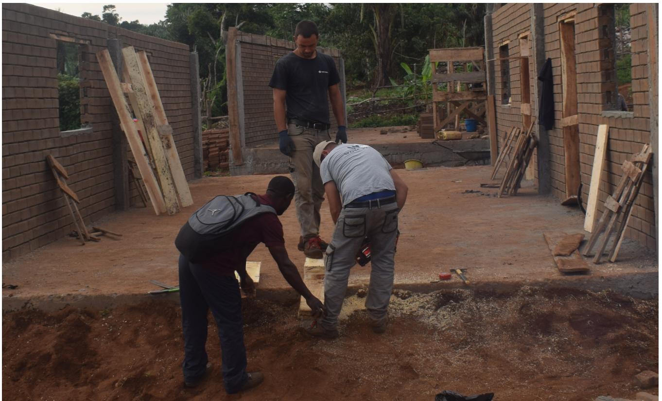
Immagine 3 – Personale italiano (Work System) e locale durante le operazioni di costruzione
