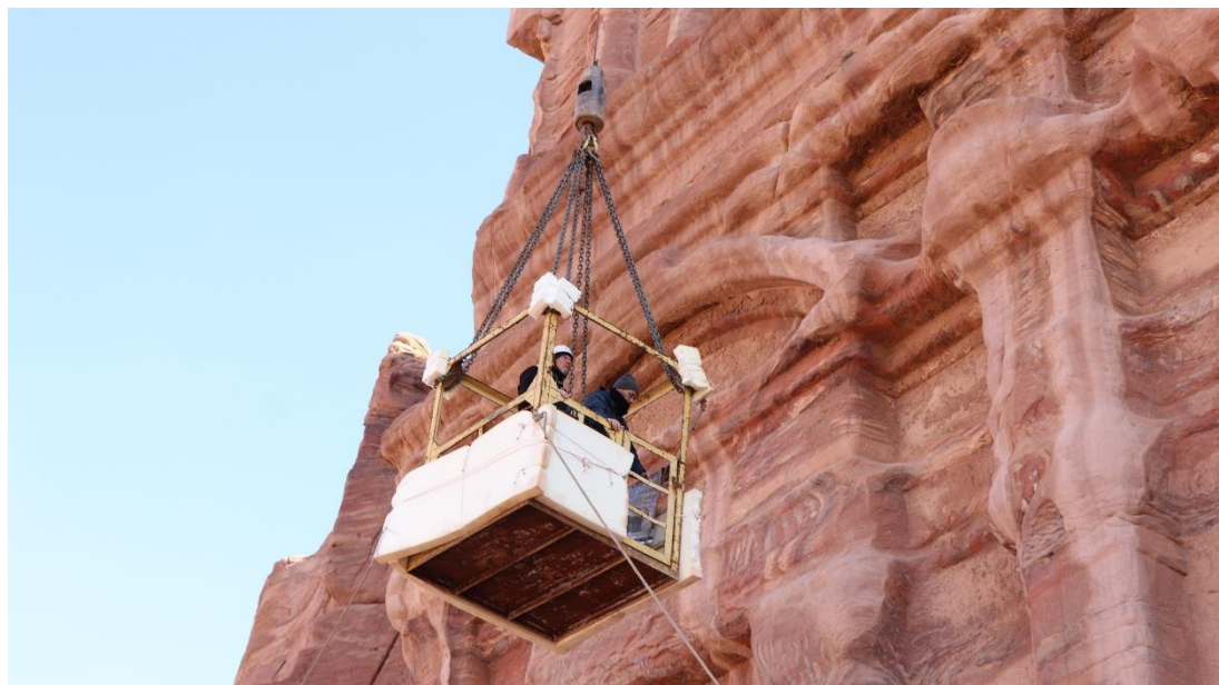
Foto 2. Progetto Siq Stability. Messa in sicurezza delle rocce del Siq - Giordania
