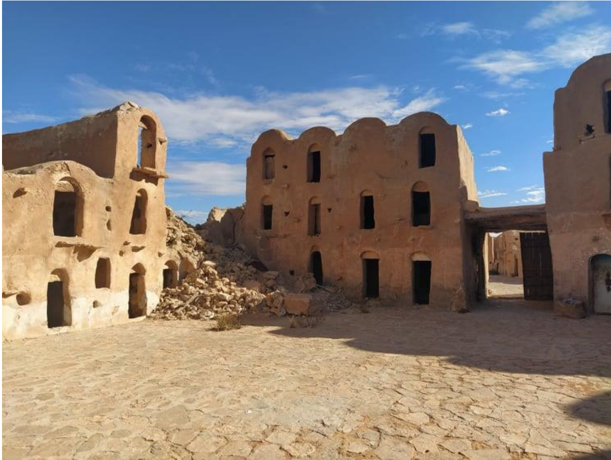
Effondrement d'une partie du Ksar Ouled Soltane, en 2019
